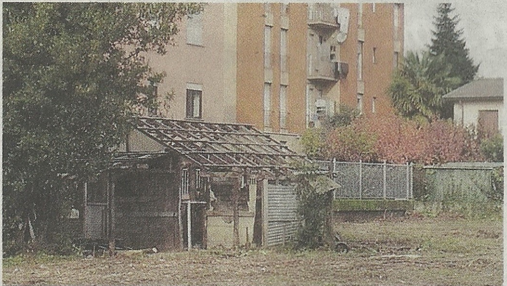
BONIFICATO Il tetto in amianto del capanno è stato eliminato e il campo pulito
